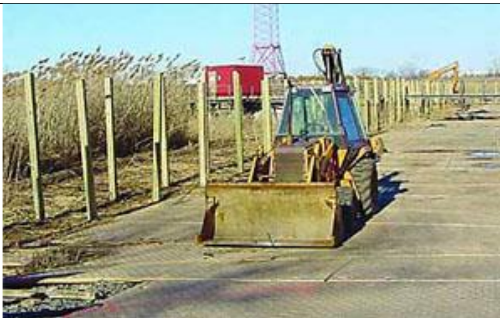
8. ábra Útmegerősítés Dura Base Mat-tal
