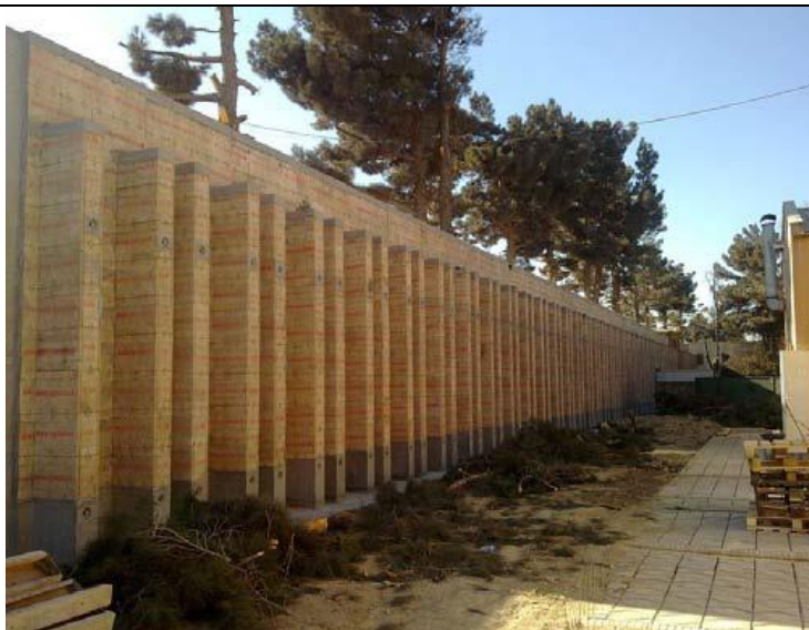
7. ábra Blokkos kerítésszerkezet [5]
