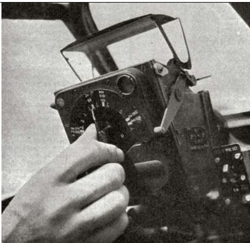
1. ábra. A Spitfirehez készített Mk II giro célzókészülék (forrás: http://spitfiresite.com/2007/11/mark-ii-gyro-gunsight.html )
