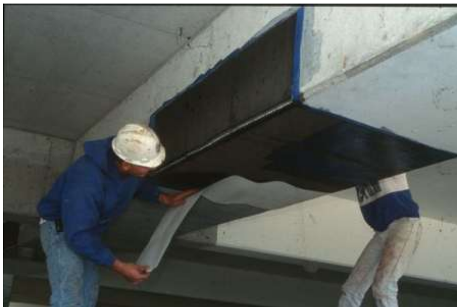
11. ábra Tartószerkezet szén-szálal megerősítése 16
