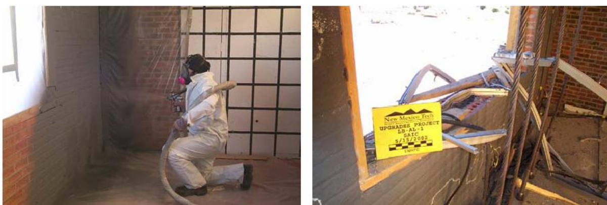
5. kép. Polimer réteg felhordása a falazatra és a teszt utáni állapot
