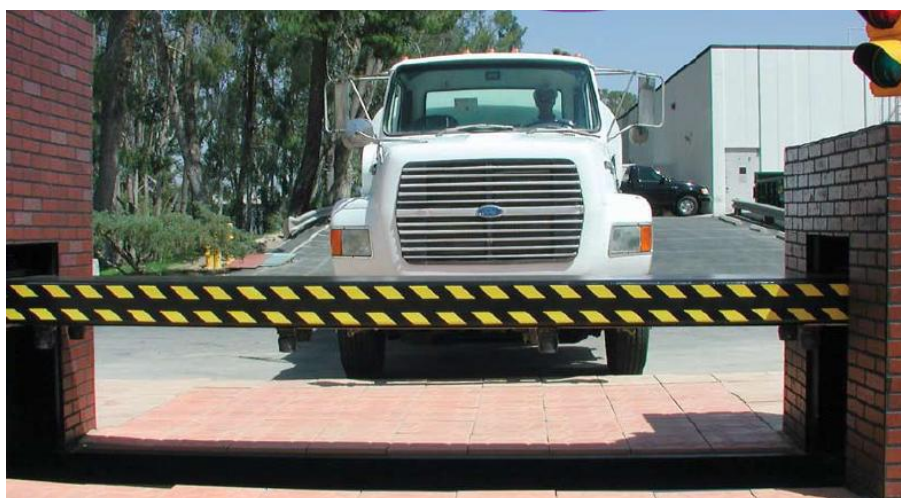
1. kép. Egy teherautó megállítására is képes sorompó
