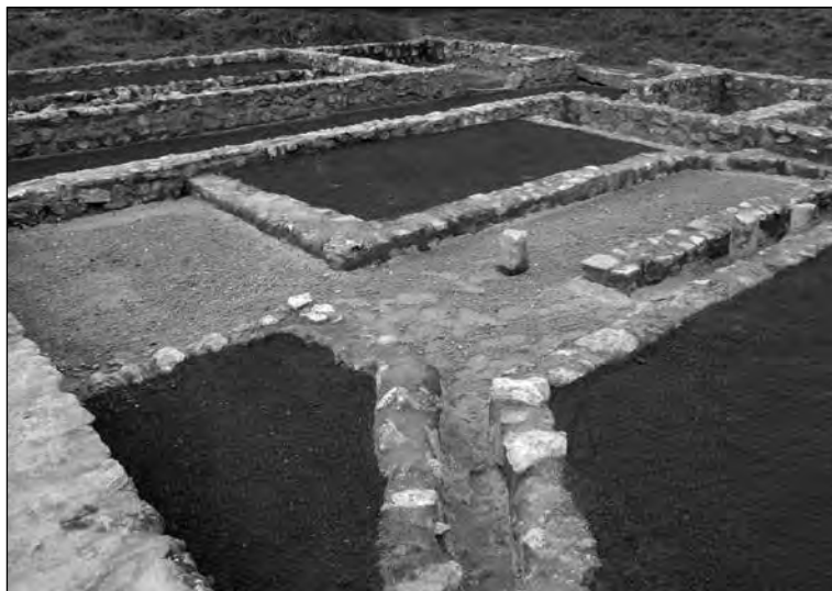
7. kép: Az épületrészlet helyreállítás után Fig. 7: The building part after reconstruction
