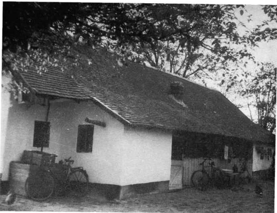
Deszkázott szinálja, a két vége beépítve
