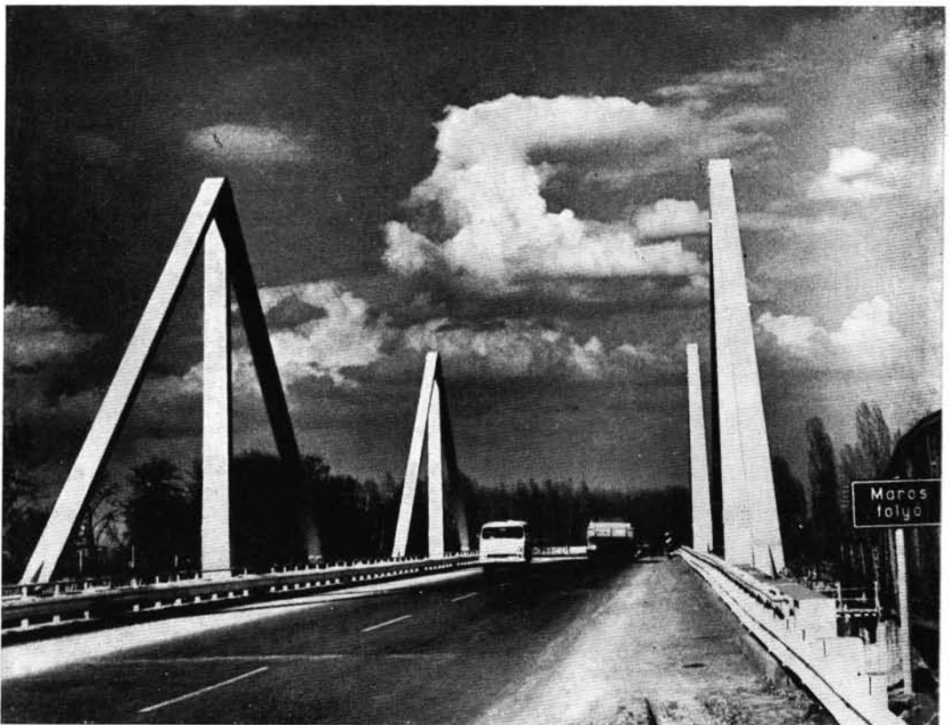
28. A forgalomnak átadott új híd
