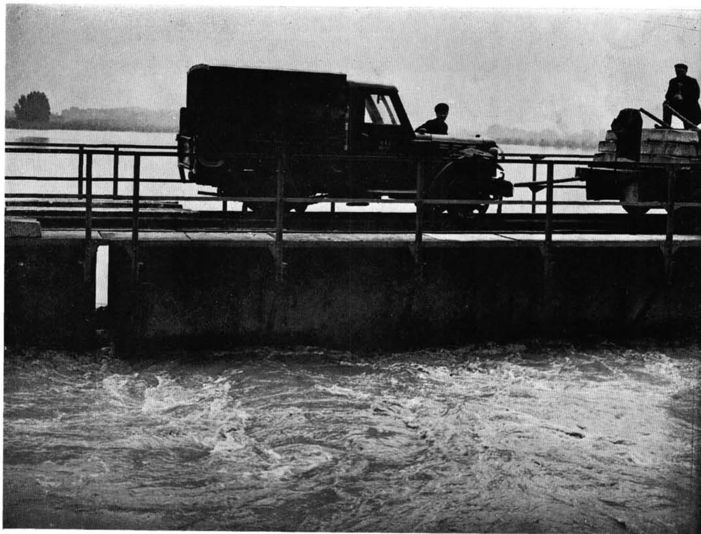
20. A makói vasúti szárazhíd az 1970. évi árvízkor
