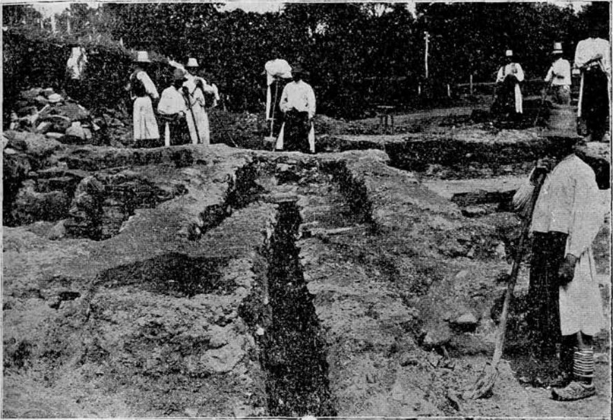
6. sz. kép. Az F és H helyiségeken átmenő csatorna.
