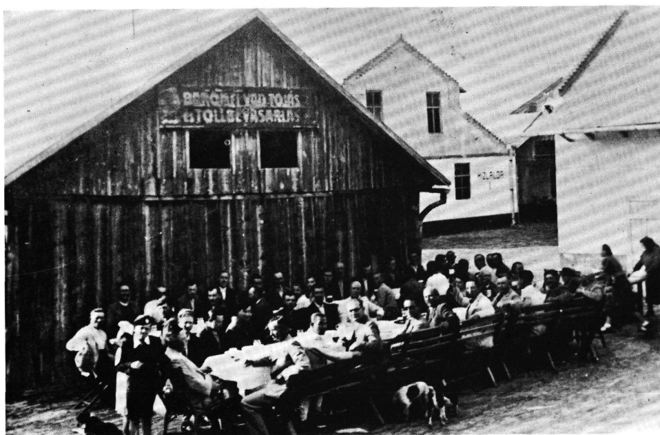
15. kép: Üzemi épületek 1939-ben. A tulajdonos Bernardinelli Lajos Bild 15: Betriebsgebäude 1939. Eigentümer ist Lajos Bernardinelli Picture 15: Proceeding-buildings 1939. Owner is Lajos Bernardinelli
