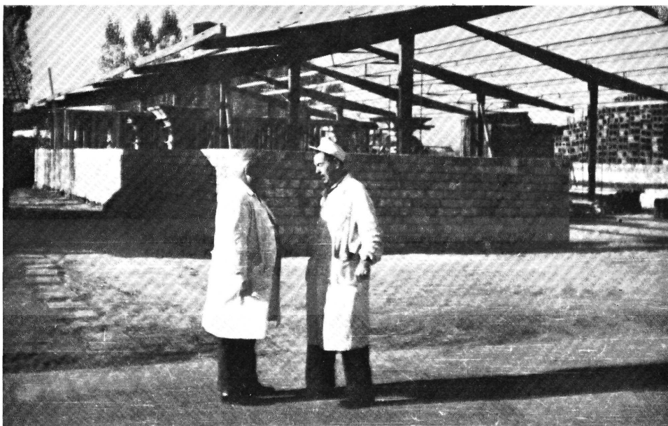
36. kép: Az I. sz. csarnok építése a konzervüzemben. 1967 Bild 36: Bau der Halle Nr. 1 im Konservenbetrieb. 1967 Picture 36: Building of the hall No. 1 in the conserve-plant. 1967
