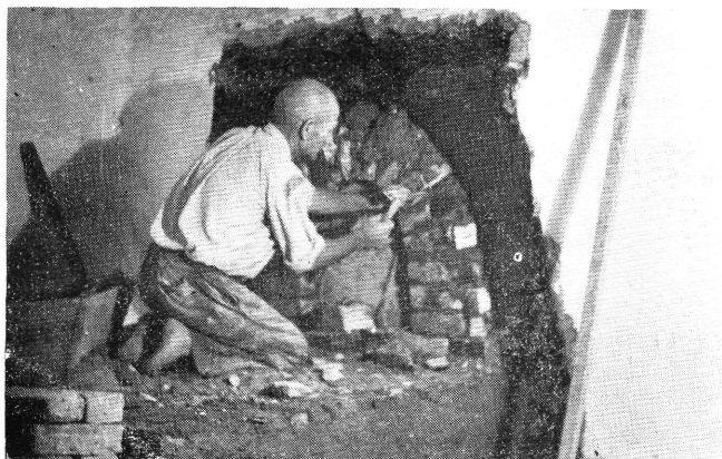
Kemence szájának készítése Hotovenie celustí pece Anfertigung des Ofenlochs
