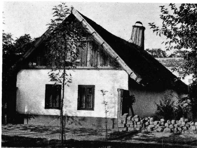
Deszkaoromzatú ház deszkakéménnyel Doštený štít a komin Haus mit Bretterbekrönung und Bretterrauchfang
