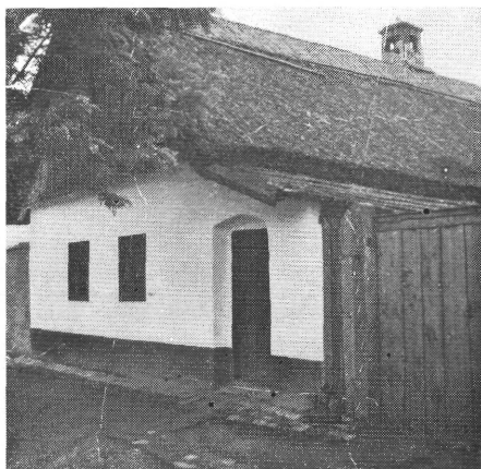
Lakóház. Botond utca 15. sz. Obytný dom Wohnhaus. Botond utca 15
