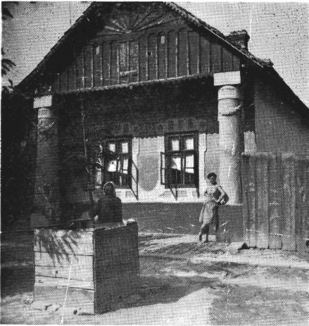
Oszlopos ház (1841). Toldi utca 17. sz. Střpový dom (1841) Haus mit Säulen (1841). Toldi utca 17
