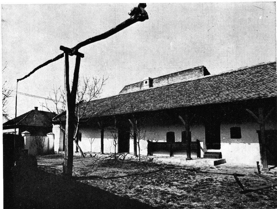
15. kép: A Garai u. 21. sz. lakóház udvari homlokzata, helyreállítás után. (foto: Remeckzy Ferenc) Figure 15: Court-yard face of the dwelling at 21 Garai St., after restoration (photograph by Ferenc Remeckzy)
