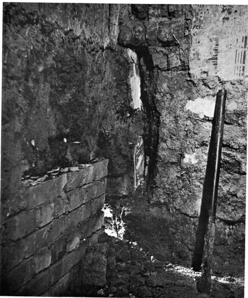
11. kép: A közbenső falak utólagosan épültek. (foto: Remeczky Ferenc) Figure 11: The more recently built intermediate walls (photograph by Ferenc Remeczky)
