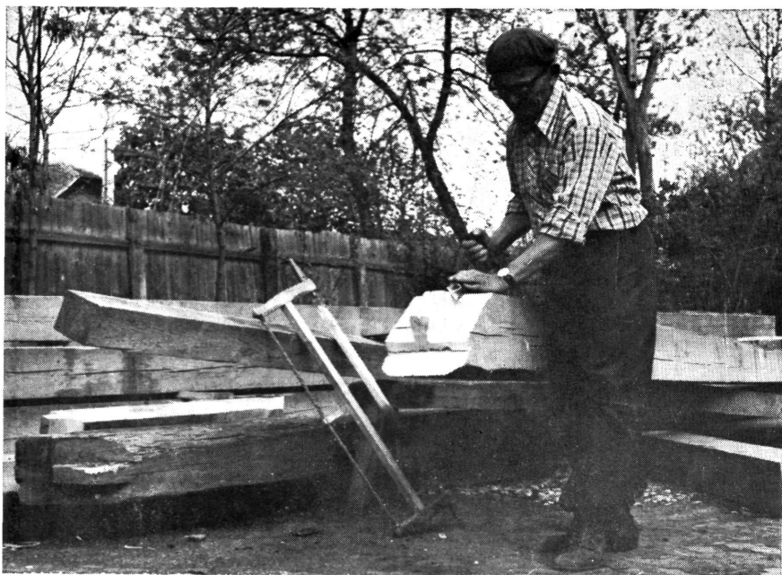
17. kép: Új szarufa csapjának készítése Figure 17: Preparation of a new blade pin
