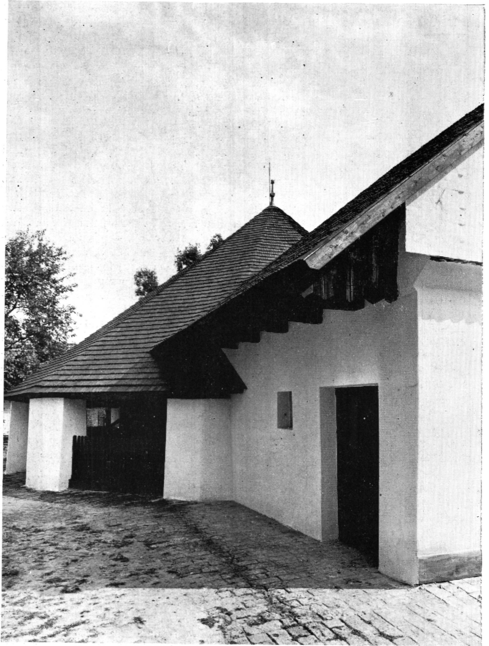
24. kép: A szárazmalom, helyreállítás után Figure 24: The horse-driven mill, after restoration
