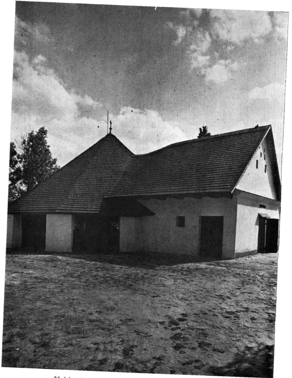
23. kép: A szárazmalom a bejárat felől, helyreállítás után Figure 23: The horse-driven mill, from the entrance, after restoration
