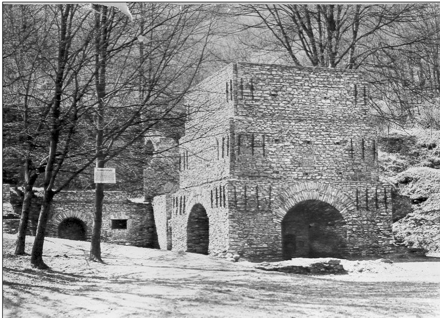
Magyarország első ipari műemléke, az 1813-ban épített faszenes újmassai nagyolvasztó
