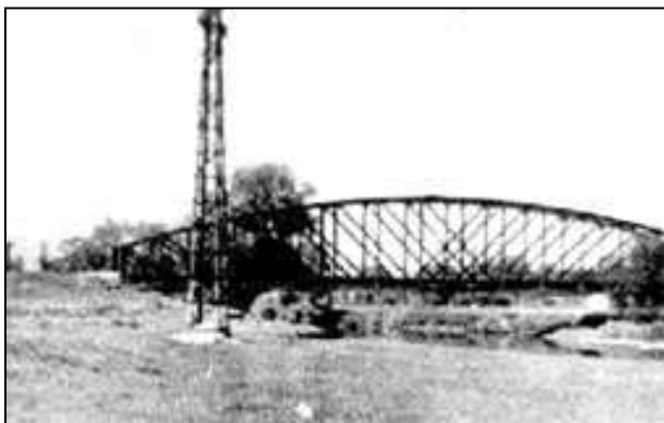
5. kép. Acélszerkezetű vasúti híd a Sajó felett, az 1000 mm-es nyomtávú pályán, Barcika vasútállomás térségében, 1899-ben épült 25
