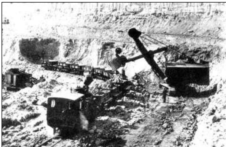
8. kép. 500 mm nyomtávú bányavasút és gőzmozdony Rudabányán
