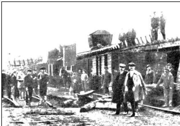
4. kép. A barcikai „átdöntő állomás”. Itt történt az 1000 mm-es iparvasúti kocsik kidöntése a normál nyomtávú vagonokba
