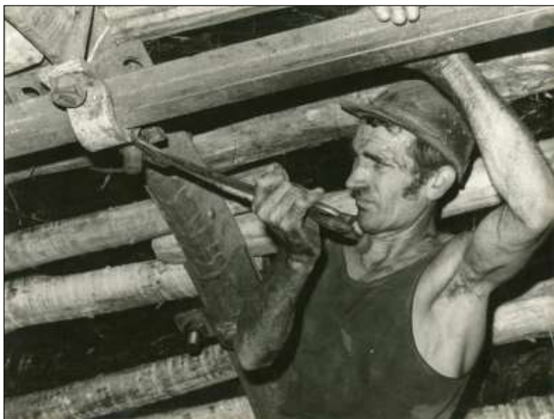
Vastám-szerelés az Ormosi Bányüzemben, az 1970-es években. (Forrás: Bányászattörténeti Kutatások Alapítvány Archívuma)
