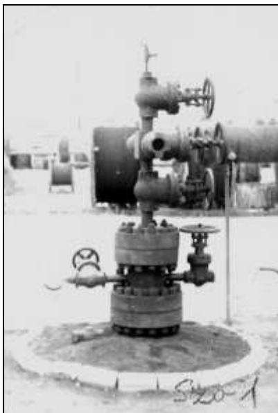
2. ábra. Az ifjú geológus egyik kutatásának eredménye a Szolnokon 1953-ban mélyített, 2443 méter mélységig „lejutó” Szo-1-es fúrásjelű lyukfej-szerelvény, vagy ahogyan becézték, a „KARÁCSONYFA”.
