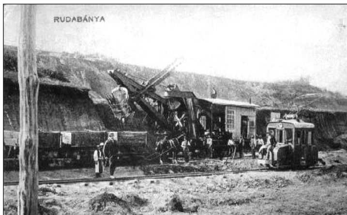
A miskolci mérnökök által megtekintett angol gyártmányú villamos kotrógép, mellette egy ugyancsak elektromos meghajtású mozdony. (Képeslap, 1905 körül.)
