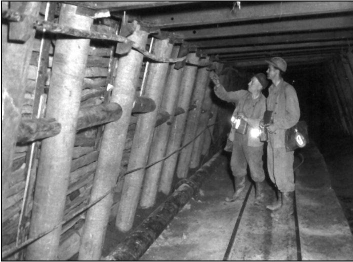
5. kép. Pörgetett vasbeton-támok Ebszönybányán.
