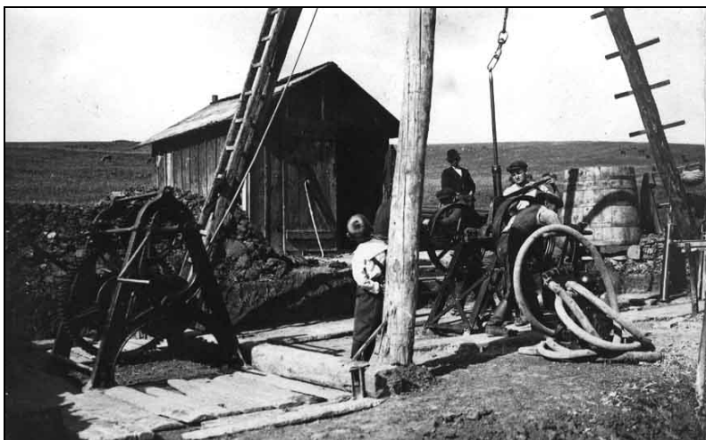
Craelius rendszerű mélyfúrógép üzemben.
