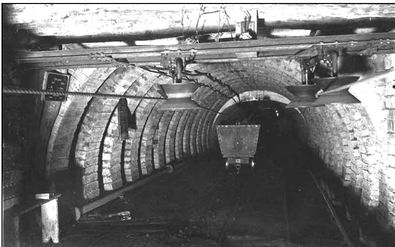
Betonműkövekkel boltozott lejtősakna-szakasz.
