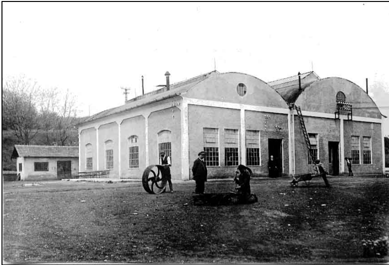
Villamos centrálé, kazánházzal.
