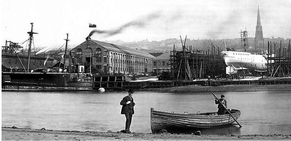
A Panther torpedóhajó törzse az elswicki hajógyárban, röviddel a vízre bocsátás előtt, 1885 júniusában. A Bal oldalon a Blanco Encalada chilei csatahajó látható, építés közben 3704
