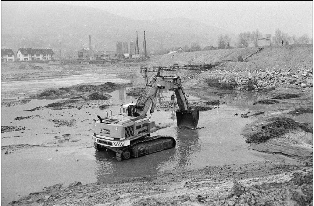
Ideiglenes Duna-meder létesítése a bős–nagyvarosi vízlépcsőrendszer építéseinél, 1988 első felében
