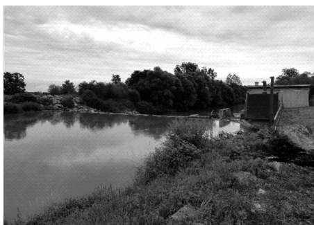
6. ábra • Megújított gát a Rábán
