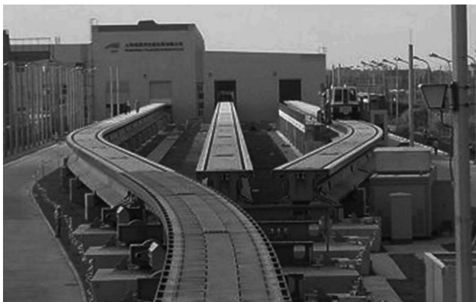
5. ábra • Háromutas kitérő Sanghajban a járműtelep tároló- és szerelévágányainak bejáratánál
