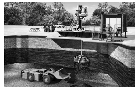
6. ábra • Légakna mélyítése gépesítéssel
