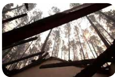
Üszkös tetőszerkezet
