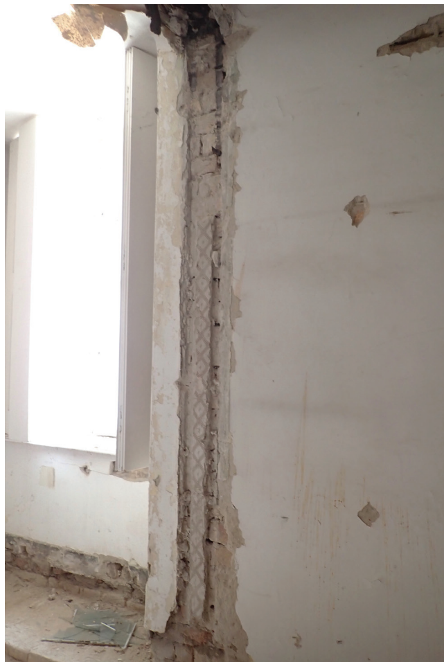
2. kép. Tapétaszélek a válaszfal lebontott helyén
