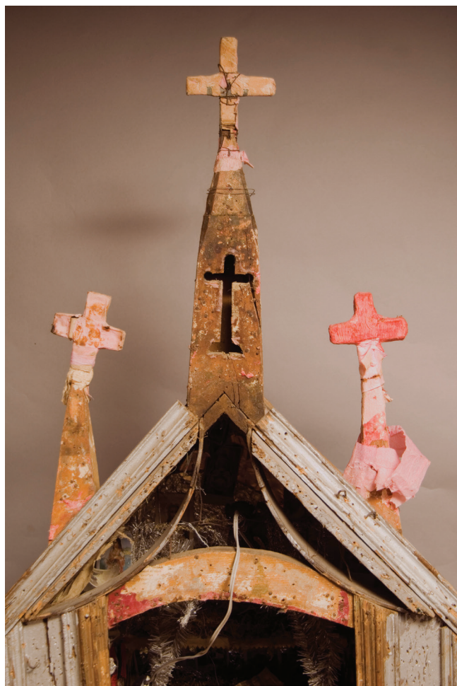
44. kép. A tornyok a borítások lebontása közben
