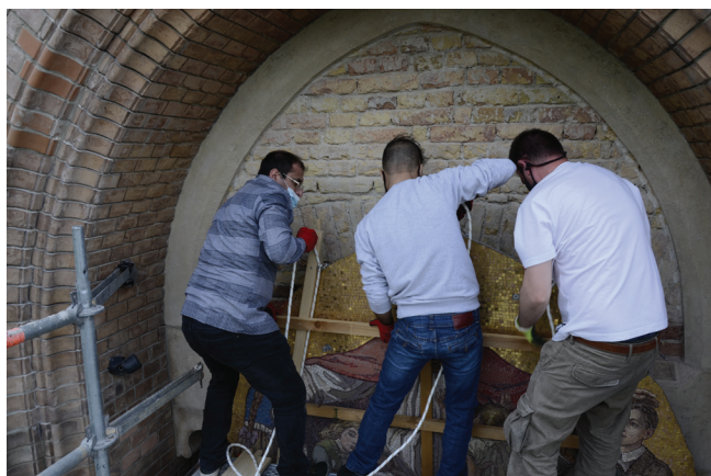
16. kép. A könnyűszerkezetes hordozóra rögzített restaurált mozaik installálása
