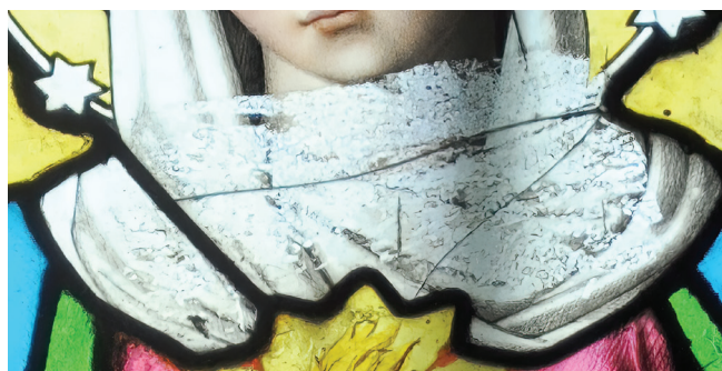
22. kép. A Mária ábrázolás nyakrészét ütés érte, az átragasztás magával rántotta a festett részeket
