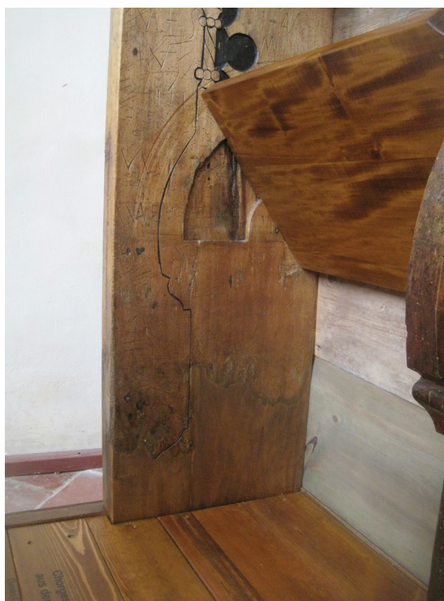
38. kép. A tömörfa kiegészítések és a rekonstruált pódium színének kialakítása vízben oldódó páccokkal történt
