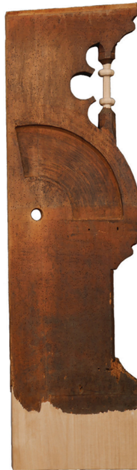
30. kép. A CNC marógéppel előállított, pontosan illeszkedő kiegészítés a megerősítő csapolással
