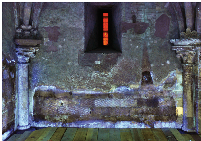
22. kép. Ugyanaz a részlet UV lumineszcens felvételen. A korábban alkalmazott sónyhító pakolás környezetében nagyon feldúsultak a sók, erőteljesen világítanak. Az előző felvétel bizonyítja, hogy ebből szabad szemmel semmit nem lehetett érzékelni
