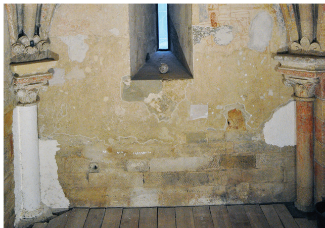
23. kép. A legintenzívebb sófeldúsulásokra hónapokig tartó szívópakolást tettünk. Később a sókat mosással és gőzzel próbáltuk legalább részben eltávolítani. A munka befejeztével ezekre a felületekre évekig fennmaradó áldozati vakolatot tettünk
