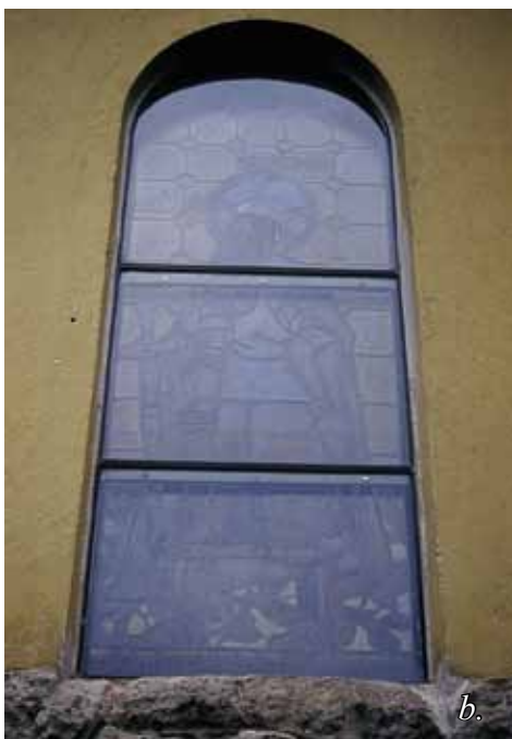
b. A üvegfestmény elé a védőrács eltávolítása után külön fémkeretbe helyezett, kétrétegű, belső fóliával megerősített, ragasztott biztonsági üveg került. A védőüveg alosztásai követik az üveglablak mezőméreteit.
