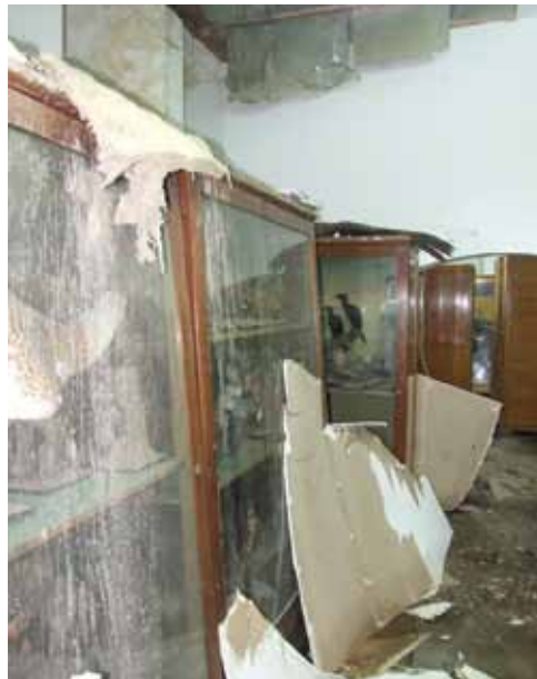
1. kép. A beázott raktárhelyiség részlete. Leszakadt mennyezet, padlót ellepő törmelék, beázott szekrények.
