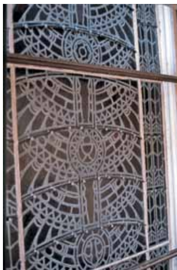
21. kép. Restaurált panelek ívesen maghajtított merevítővasal a keretbe rögzítve, beépítés után a külső oldalról.
