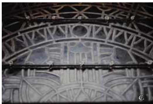
11. kép. Lipótmezei kápolna, Budapest. a. A templomhajó vetemedett, szennyeződésektől fekete ablakának részlete, belső oldal, restaurálás előtt. b. A restaurált ablakmező. c. A restaurált mező hajlított merevítővassal, rózsakötéssel, a beépítés után a külső oldalról.
