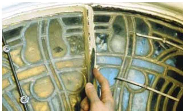
20. kép. A visszaépített üvegpanelek széleinek hézagtomítása lenolajkencés hegyikrétaival.
