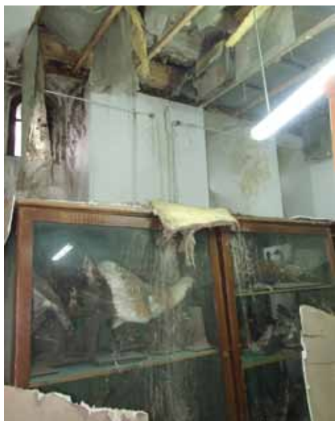
3. kép. A beázott szekrényekre zuhant meny- nyezet.
