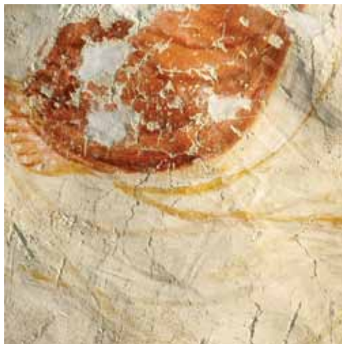
2. kép. Bádok, a hajó falképei. A vakolat felszínének eldolgozásához használt spatula nyomai jól láthatóak sűrűfényben.
