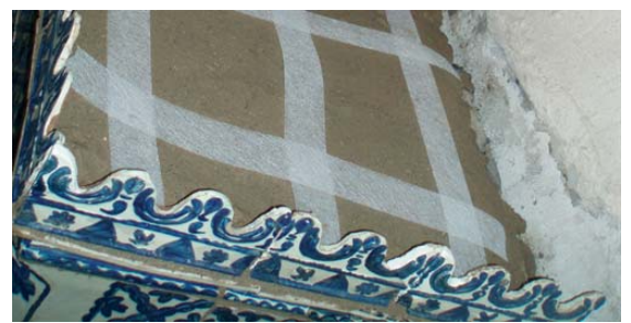
27. kép. A tető megerősítése tüvegyszerrel.
