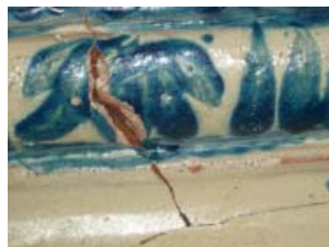
15–16. kép. Párkányelem ragasztása és tömitése.
