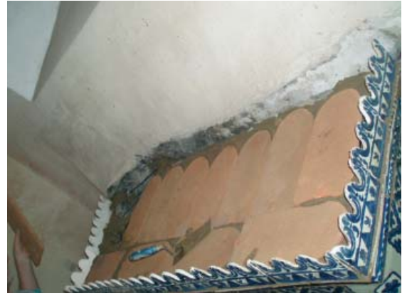
26. kép. A tető fődése.
