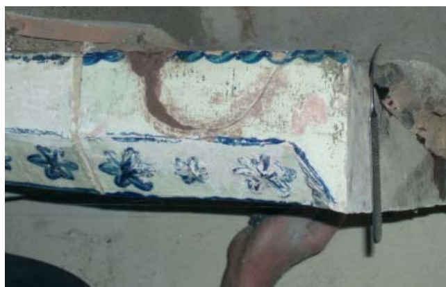
22. kép. A helyükön maradt elemek in situ kiegészítése.
