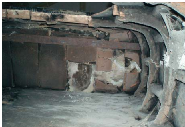
31. kép. Bordakialakítás a csempelapok peremén.
