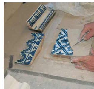
18-19. kép. A hiányos csempelapok kiegészítése tűzálló agyaggal.
