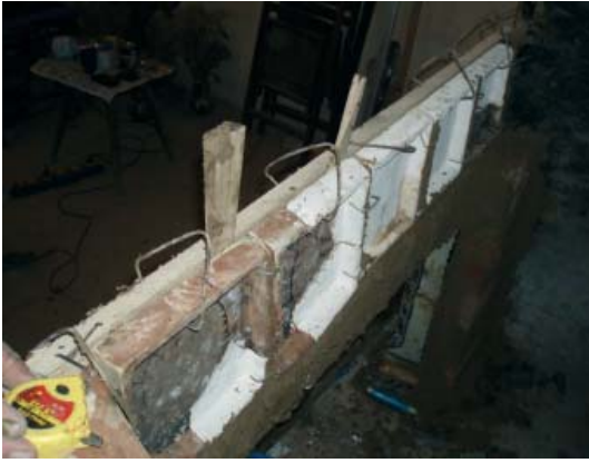
23. kép. Az összeépítés, részlet.
