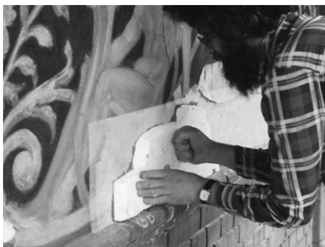
28. ábra. Andrassy út 102. A leválasztott bal oldali freskó-részlet visszaillesztése a helyére.
