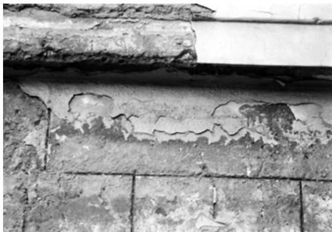
7. ábra. Kváderozott felület, a kváderek illesztéseinél alkalmazott fekete, finom vakolatból készült illesztés-imitációkkal a Magyar Nemzeti Múzeum épületén a legutóbbi helyreállítás előtt.
