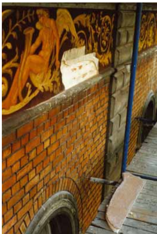
35. kép. Andrásy út 102. A visszahelyezett bal oldali freskó-részlet kiretusálva. A jobb oldali freskó-részlet visszahelyezésének előkészítése.
