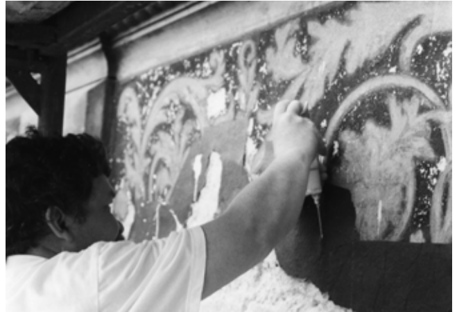
24. ábra. Bajza utcai homlokzat: injektálás meszes-ammónium-karbamátos anyaggal. A japánpapíros átragasztás két okból volt szükséges: azért, hogy az elvált vakolat ne essen le, és hogy a festést védjük a kifolyt injektáló-anyagtól. (Gyöpös Miklós)
