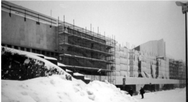
4. ábra. A márvány burkolat cseréje a Finlandia palota öböl felőli homlokzatán.
