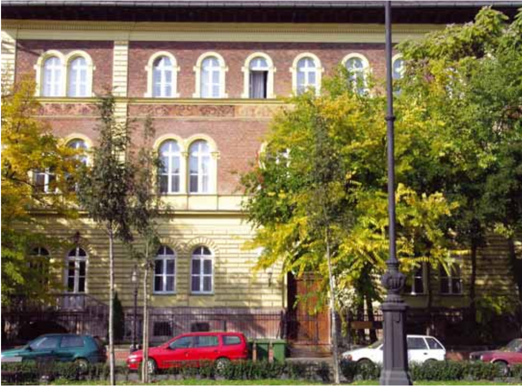
26. kép. Andrassy út 102. (Bajza utca 38.) A palota második emeleti ablaksora alatti frízen Lotz Károly freskói, az ornamentikát minden bizonynal Scholz Róbert munkatársai festették. Az Andrassy úti homlokzat restaurálás után.
