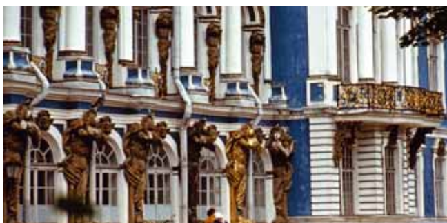
8. kép. A Carszkoje Szjelo-i cári palota kékre festett homlokzata. Az egyik kariatidán érzékeltetni próbálták, hogy a barnának látszó részek eredetileg aranyozva voltak.
