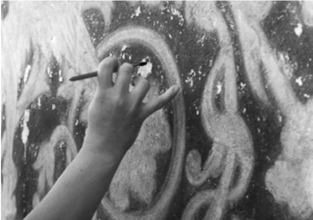
22. ábra. Andrásy út 102. Fischer és Sonnenberg palota. Bajza utcai homlokzat: a vakolathiányok és a barna alapszín itatása desztillált vízzel hígított Syton X 30-al.
