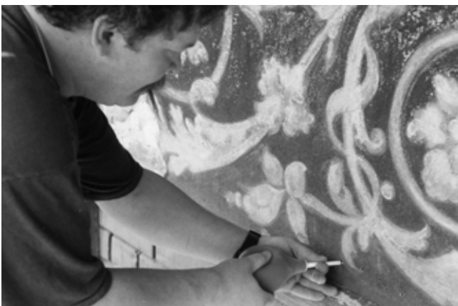
23. ábra. Bajza utcai homlokzat: az üregek portalanítása az injektáló lyukakon keresztül gumi pumpával. (Gyöpös Miklós)
