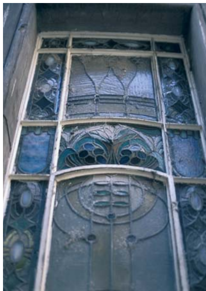
2. kép. Háborús bombatámadás okozta felületi deformációk
