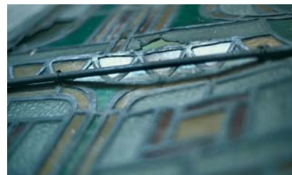
3. kép. Ólmozott mező felületi deformációja
