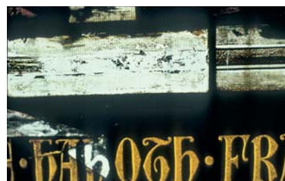
16. kép. Lepergett festékrétegek, helytelen üvegpótlás
