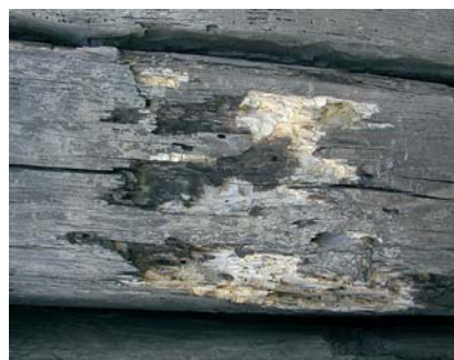
12. kép. Rovar és gomba kártétel
