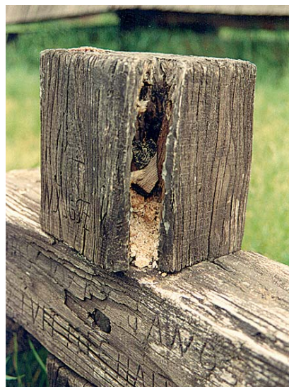
8. kép. Faodvasító lóhangya kártétele
