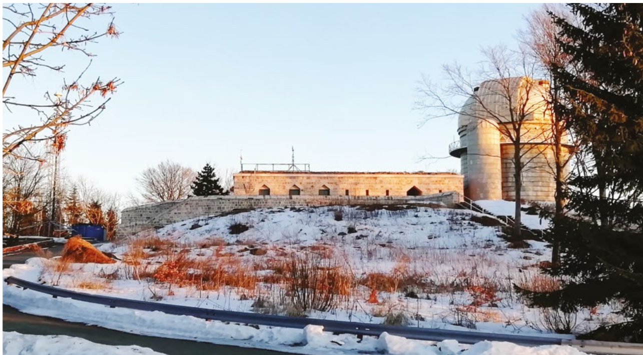
1. ábra. A Piszkéstetői Observatórium méteres távcsövének épülete
