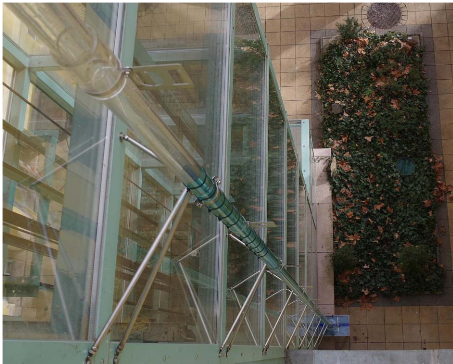
A fagyálló hűtőfolyadékkal feltöltött Torricelli-cső a Szegedi Tudományegyetem Juhász Gyula Pedagógusképző Kar főépülete udvari liftjének oldalán.
