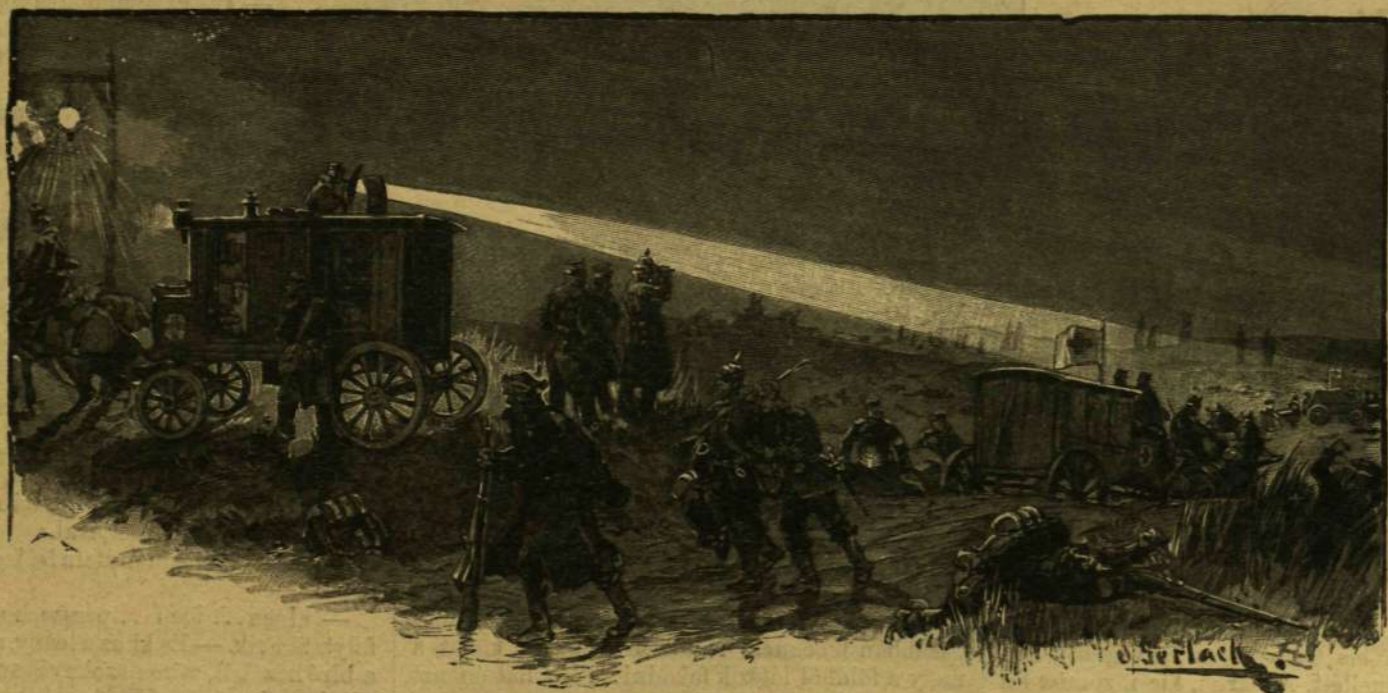
SEBESÜLTEK FÖLKERESÉSE A CSATATÉREN VILLAMOS FÉNYVETŐ MELLETT.
