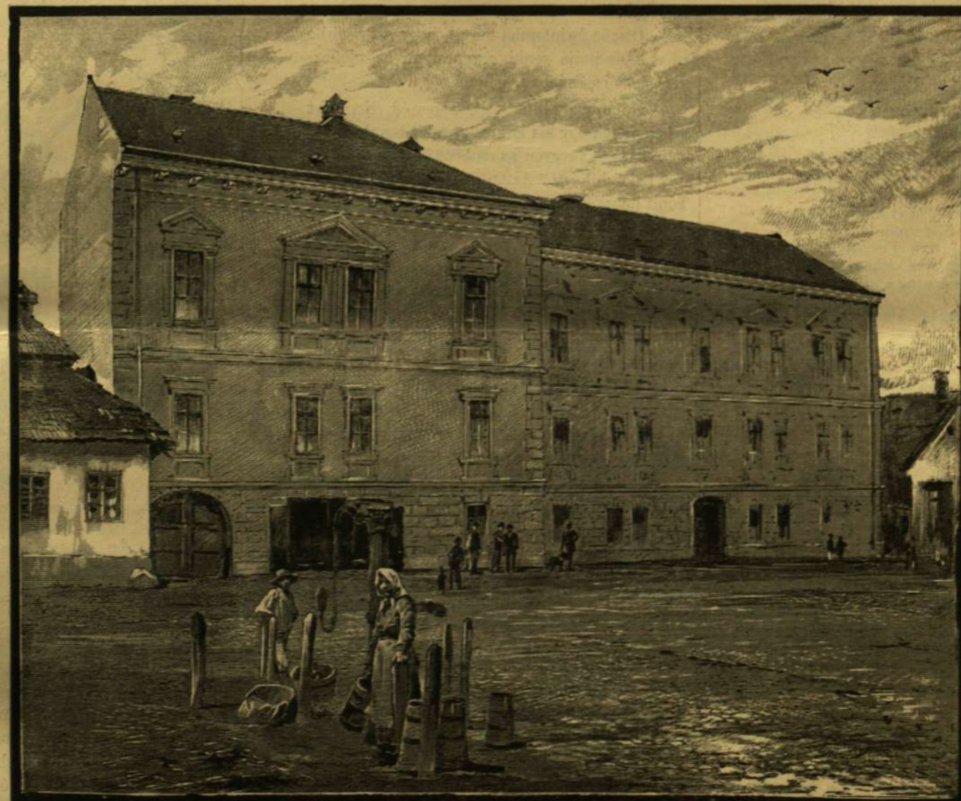
A SZÉKELY-UDVARHELYI KOLLEGIUM MEGÚJÍTOTT ÉPÜLETE.
